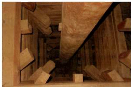
心柱 五重塔内部見上げ 心柱は見えない部分 を八角形、径470mm の杉柱、手斧の工具 痕がはっきりと残る。 本来は基礎から相輪 まで80m程で1本であ ったと考えられるが、 大正期の修理により 3本に継がれている。
