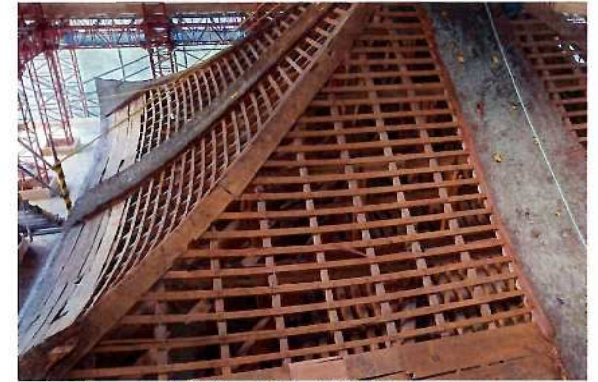
5重屋根 檜皮葺解体・調査 野地板の状況
