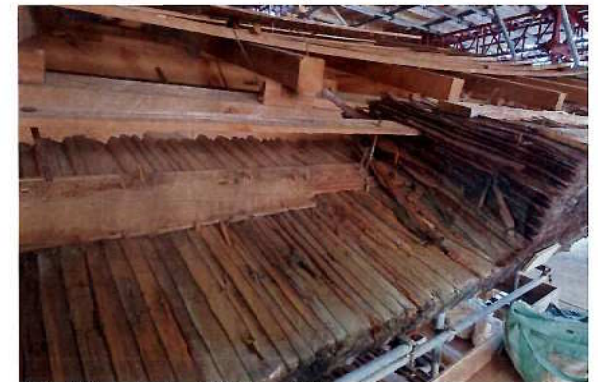
軒先解体 軒積・蛇腹板の状況
